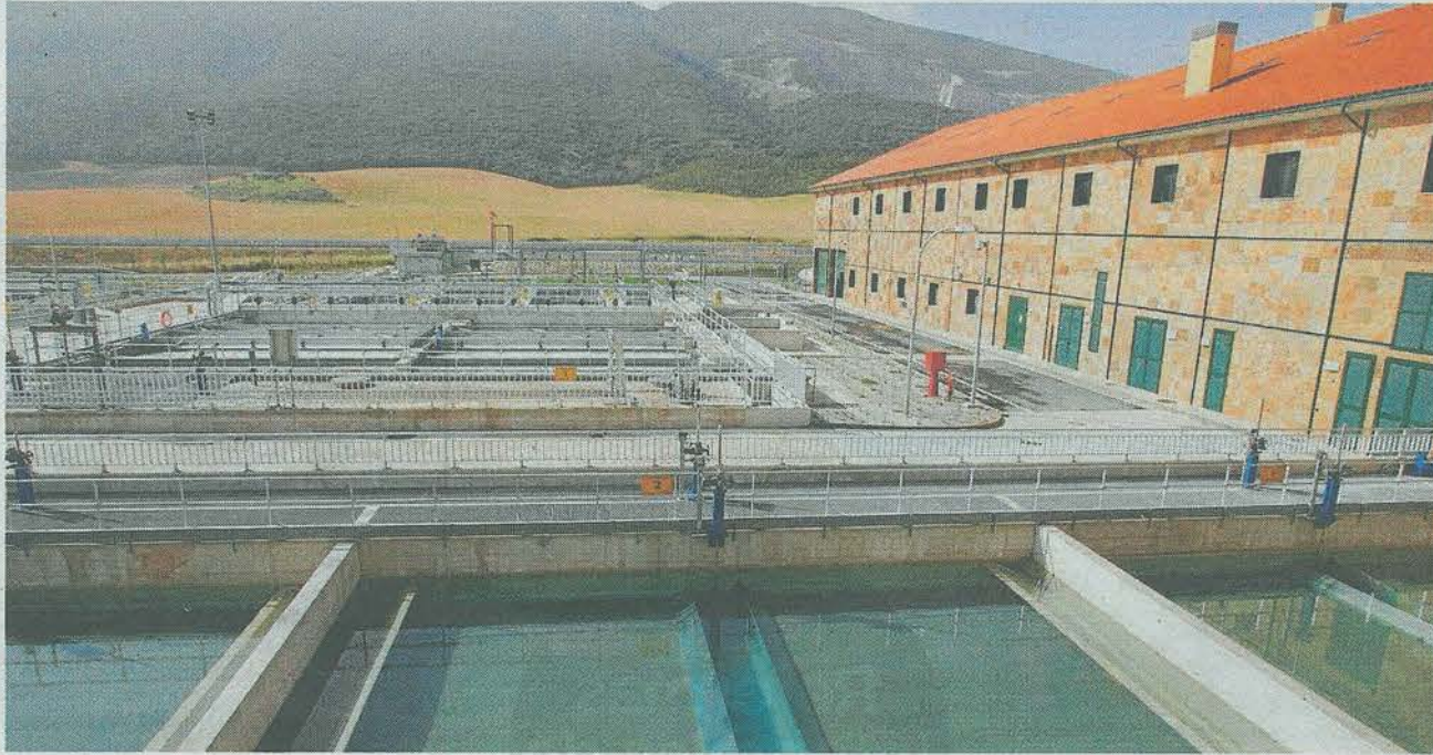
Estación depuradora de Tiebas que capta el agua del Canal de Navarra. Foto: Javier Bergasa
