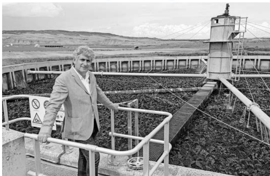
Fernando Mendoza, director gerente de Nilsa, en la depuradora de Valtierra-Arguedas, donde también se instalarán paneles solares.
